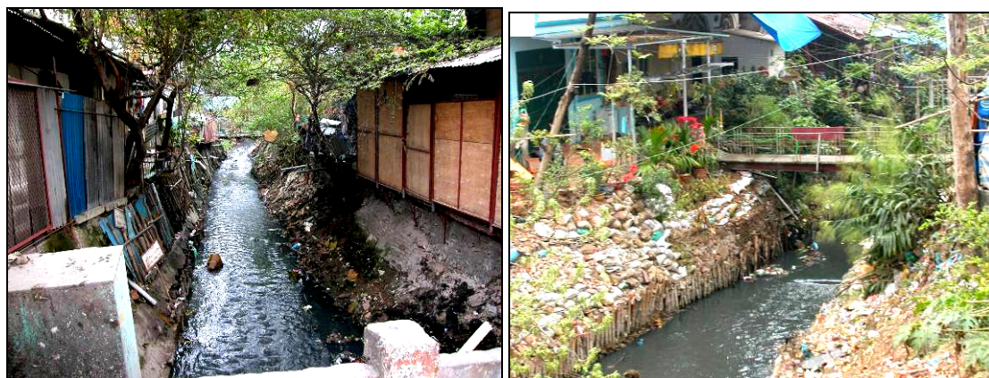
Figure 3.6 : « Canaux d'égouttage » servant également à la dérivation des flux en cas de crue (Photographie A.NOEL, 13 et 16-03-2008)
