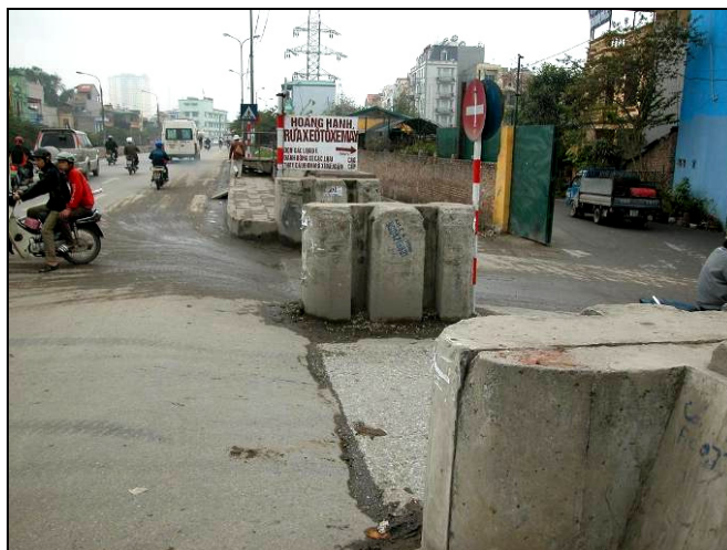
Figure 3.12 : Digue discontinue (Photographie A.NOEL 13-03-2008)
