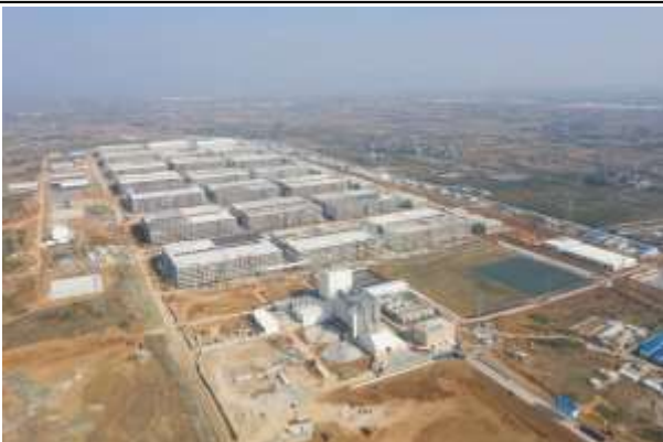
그림 3-11. 2020년 11월, 건설중인 돼지 빌딩
