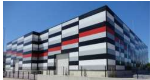
그림 2-2. 샌드위치 패널로 시공한 건물
