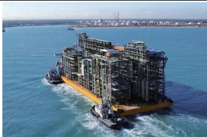
그림 2-19. Off-Site Moduling 후 해상운반 중인 모듈
