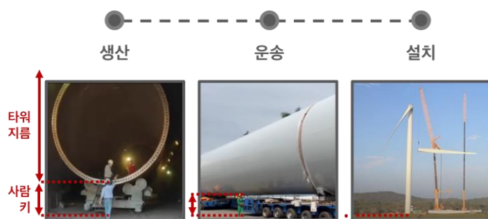
도표 3-5. 풍력 타워 설치 과정
