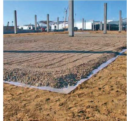
Fig. 1 - Pose de géomembrane
