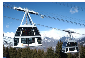
Figure 2 – Cabines se déplaçant sur une ligne
