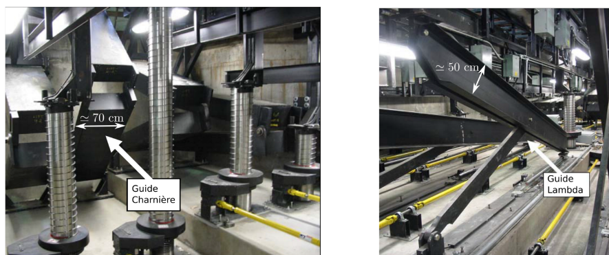
Figure 10 – Éléments de guidage d'une plate-forme
