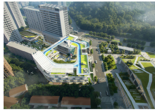
中科院武汉分院科教设施配套校区 2022, 公开竞赛第一名中标, 建设中
