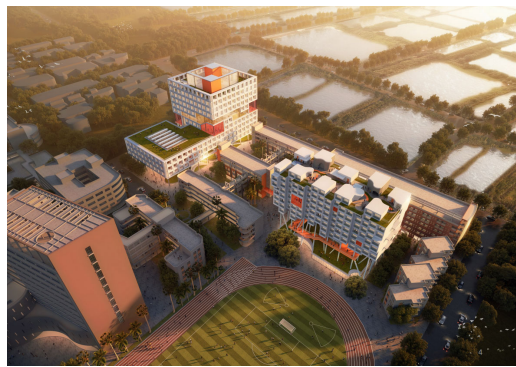
顺德实验中学提质增效工程 2021, 全国竞赛第一名中标, 建设中
