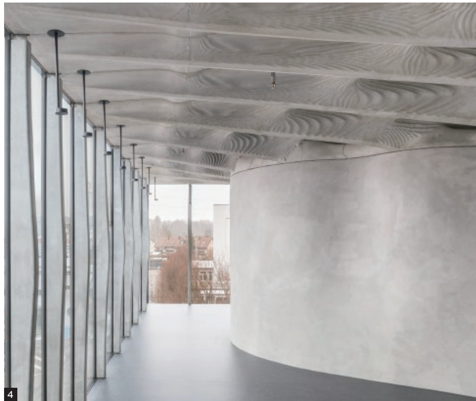
4 DFAB House室內完工照，其右側為Mesh Mould牆完成照。
