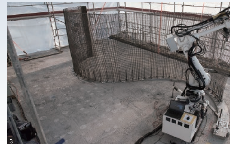
3 機械手臂的電焊Mesh Mould的過程照
