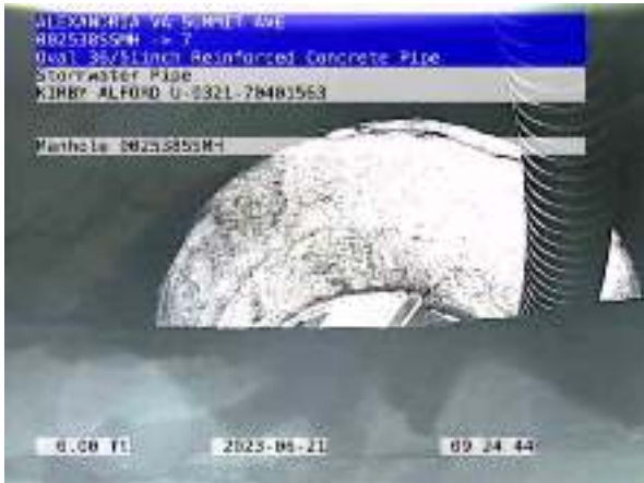
009064STMP_253ce69d-b760-44d7-87dd-26e18f25112d_20230621_095731_453.jpg, 00:00:00, 0.00ft Manhole / 002538SSMH
