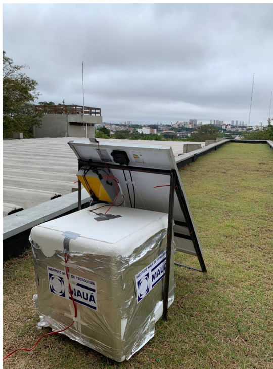
Figura 49 – Placa instalada no quarto andar do bloco W
