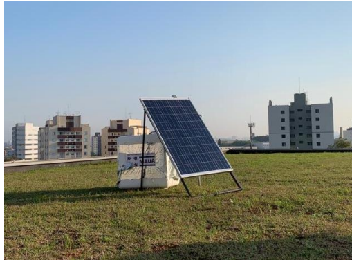
Figura 51 – Placa instalada no terraço do bloco W
