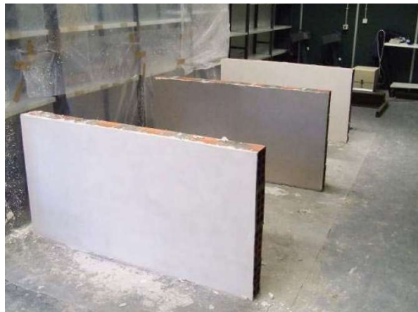
Figura 16 – Paredes revestidas com argamassas em Braga
