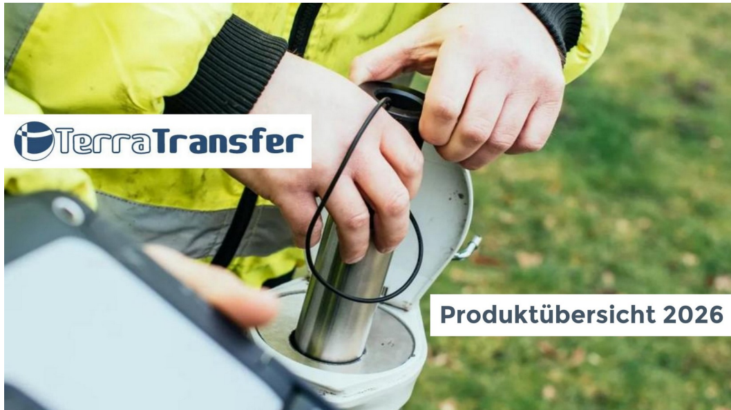
Abbildung 2: Einbau des AquatOS nano in ein Grundwasser-Beobachtungsrohr — Kabel bleibt locker, Sonde wird langsam abgesenkt.
