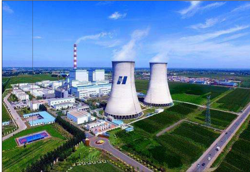
700 مېگاۋاتلىق توك ھاسىل قىلىش ئۈچۈن يىللىق 3 مىليون 820 مىڭ توننا كۆمۈر ئىشلىتىلىشى مۆلچەرلەنمەكتە (国能集团, 2020).
