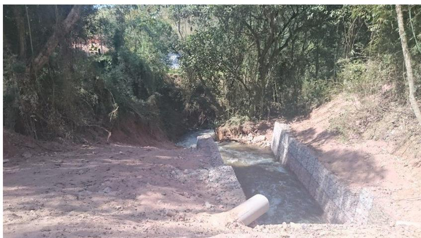
**Figura 6.** Margens degradadas do canal aberto da transposição do Rio Atibaia
