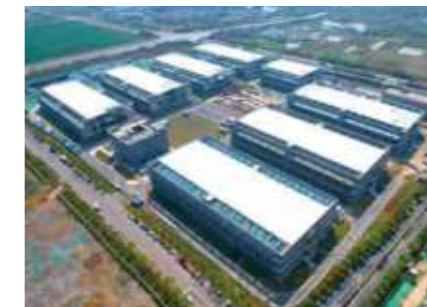
南京腾讯数据机房 NANJING TENCENT DATA ROOM
