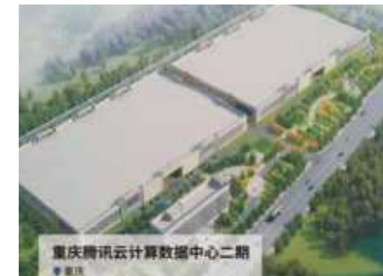
重庆腾讯数据机房 CHONGQING TENCENT DATA CENTER
