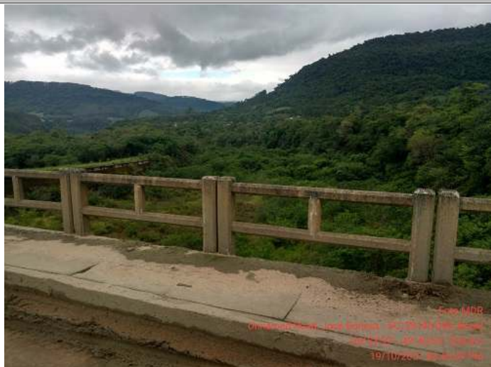
Foto 02: Trecho a ser executado do canal extravasor
