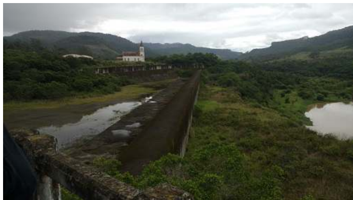
Foto 01: Início do canal extravasor
