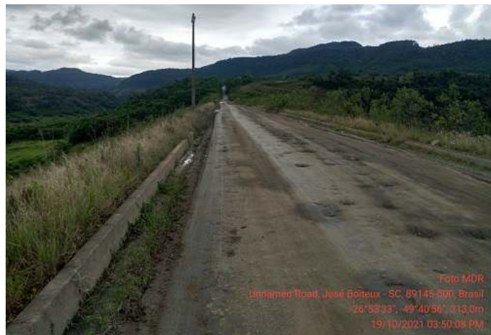
Foto 02: Crista da Barragem Norte
