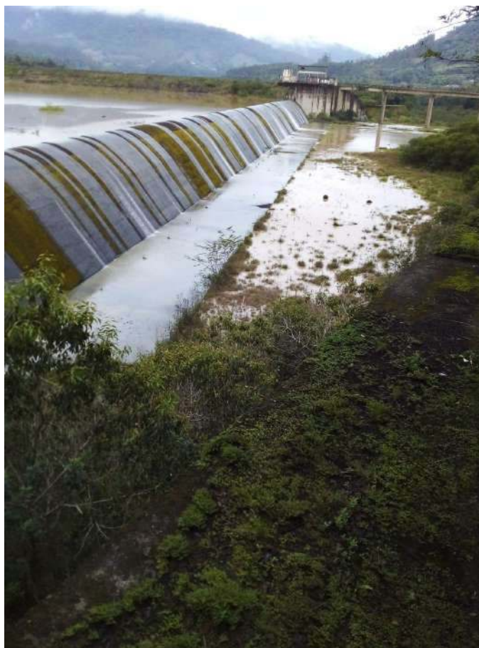
Figura 4 - Vertedouro Barragem Norte
