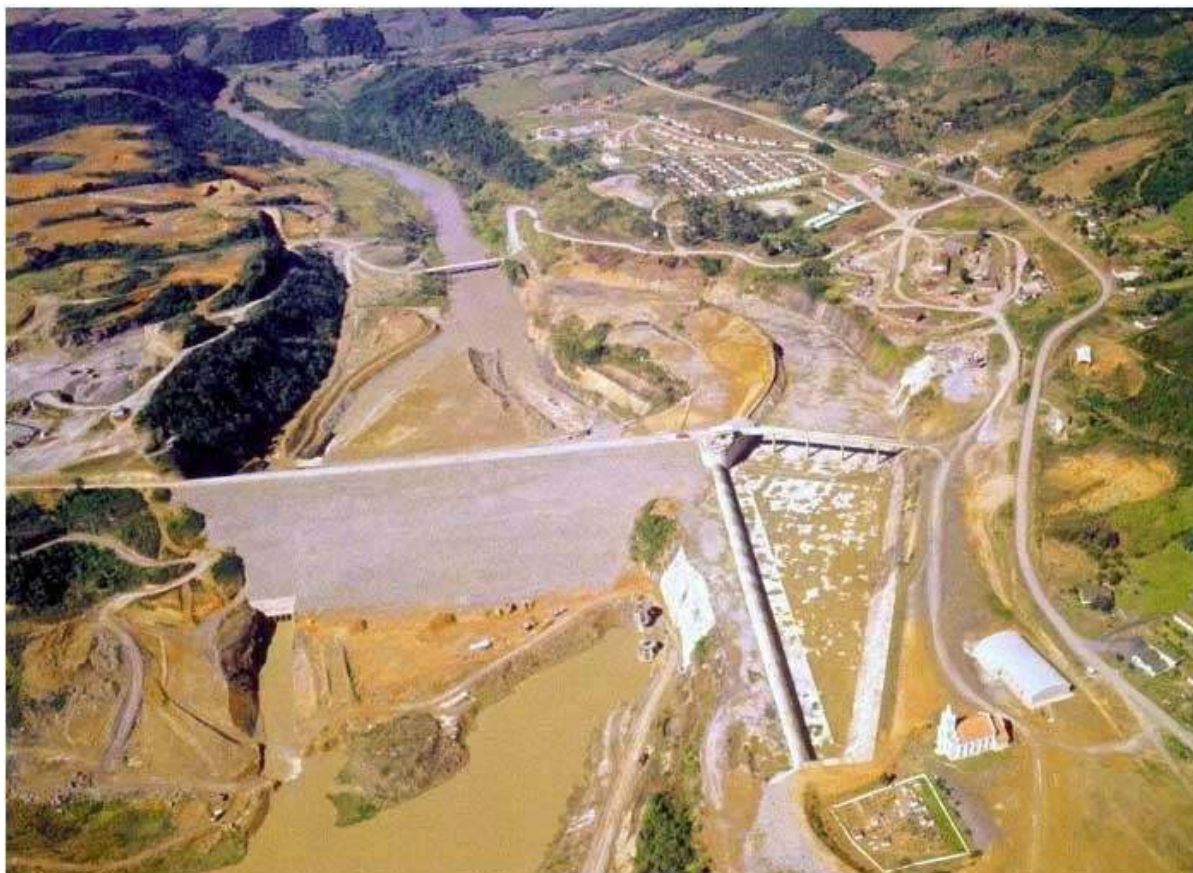
Figura 6 - Estradas e Acessos feitos durante a construção da Barragem
