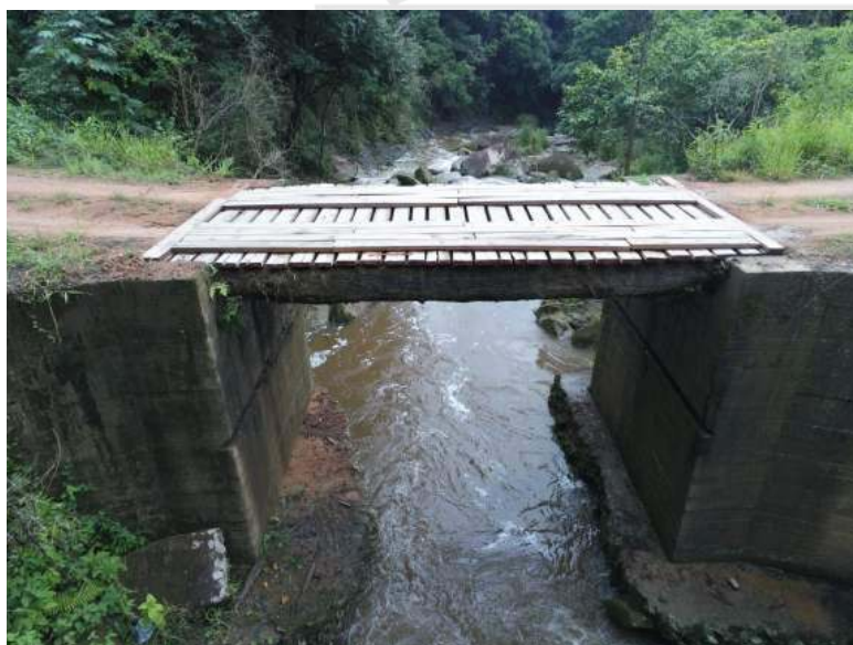
Imagem 07: Ponte sobre o Rio Platê. Coordenadas 26°49'40.46"S, 49°41'11.55"O.
