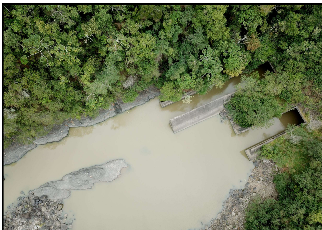
Foto 40 - Margem esquerda do canal a jusante da saída dos túneis onde se formou uma bacia devido a erosão.
