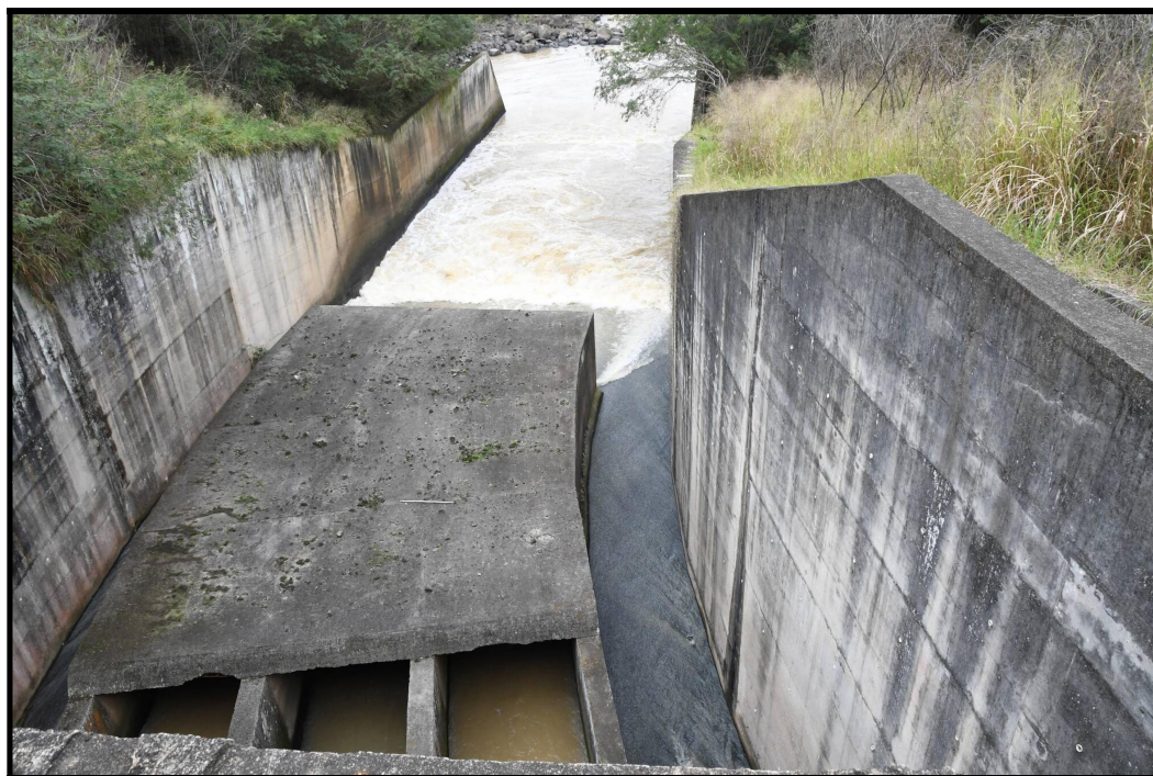
Foto 16 - Vista Geral da Estrutura de Saída da Galeria de Descarga em bom estado geral
