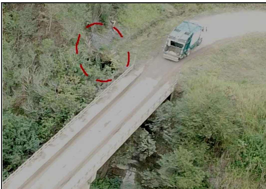
Foto 69 – Vista geral do encontro direto da ponte com drenagem da estrada terminando no talude.
