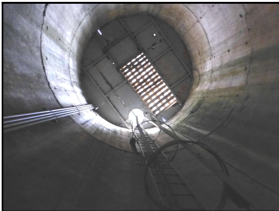
Foto 50 – Revestimento do poço de acesso à Galeria das Comportas.
