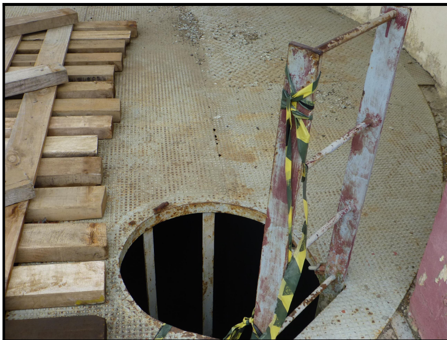
Foto 52 – Boca de Acesso à Escada de Marinheiro do poço de acesso à Galeria das Comportas
