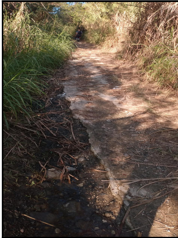
Foto 71 - Trecho da estrada a jusante da barragem, situado na margem direita, com pontos localizados de erosão e crescimento de vegetação (coord. 26°53'38.38"S, 49°40'35.00"O).
