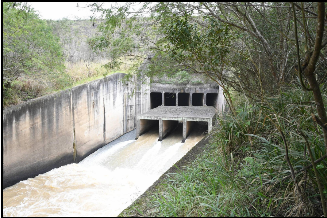
Foto 17 - Vista de jusante da Estrutura de Saída da Galeria de Descarga, notando- presença de árvores e arbustos ao lado da parede laterais do canal de restituição.
