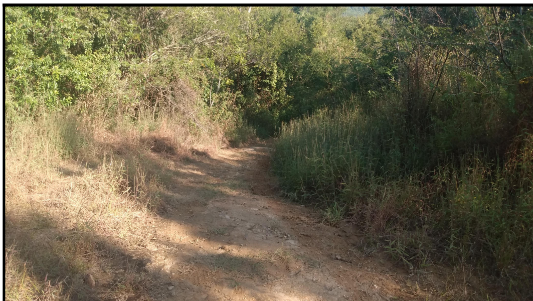
Foto 70 - Trecho a ser recuperado da estrada a jusante da barragem, na margem esquerda (coord.: 26°53'23.90"S, 49°40'22.01"O).
