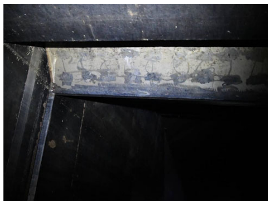
Foto 26 – Parte Inferior da comporta do Túnel Interno.
