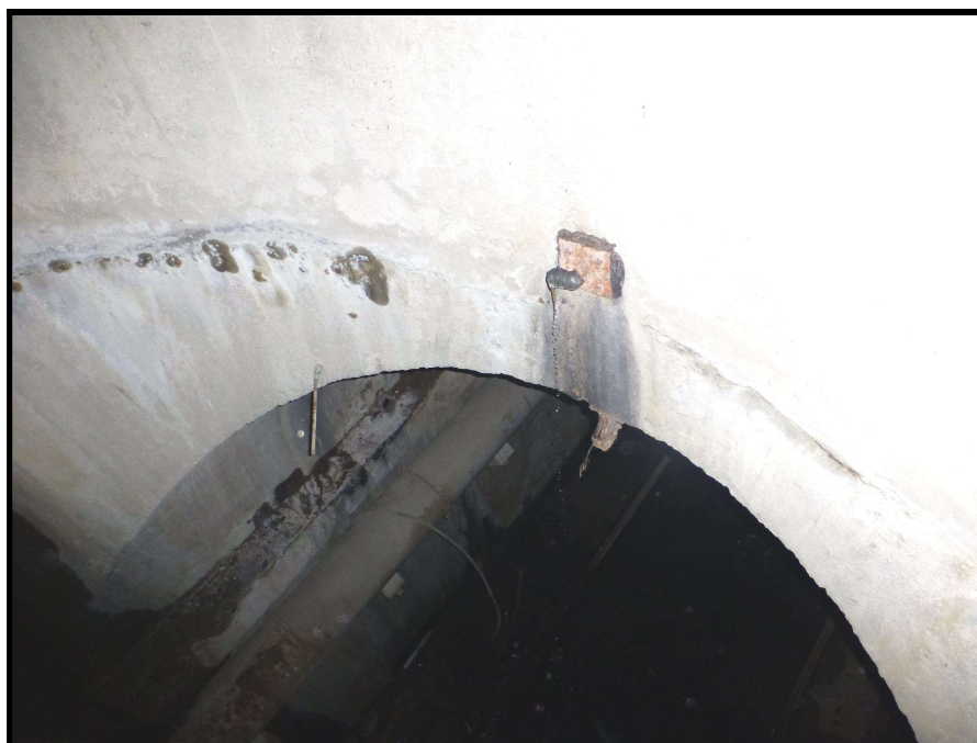
Foto 51 – Revestimento de concreto da Galeria das Comportas.
