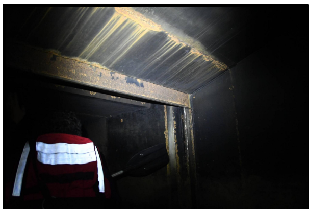
Foto 29 – Batente da comporta do Túnel Externo em bom estado.
