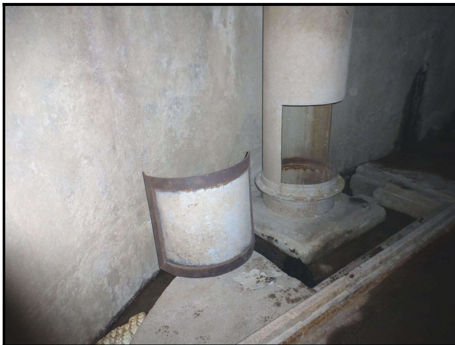
Foto 64 – Pórtico Móvel de Manutenção das Comportas de Controle de Vazão, onde se vê abertura para ventilação.
