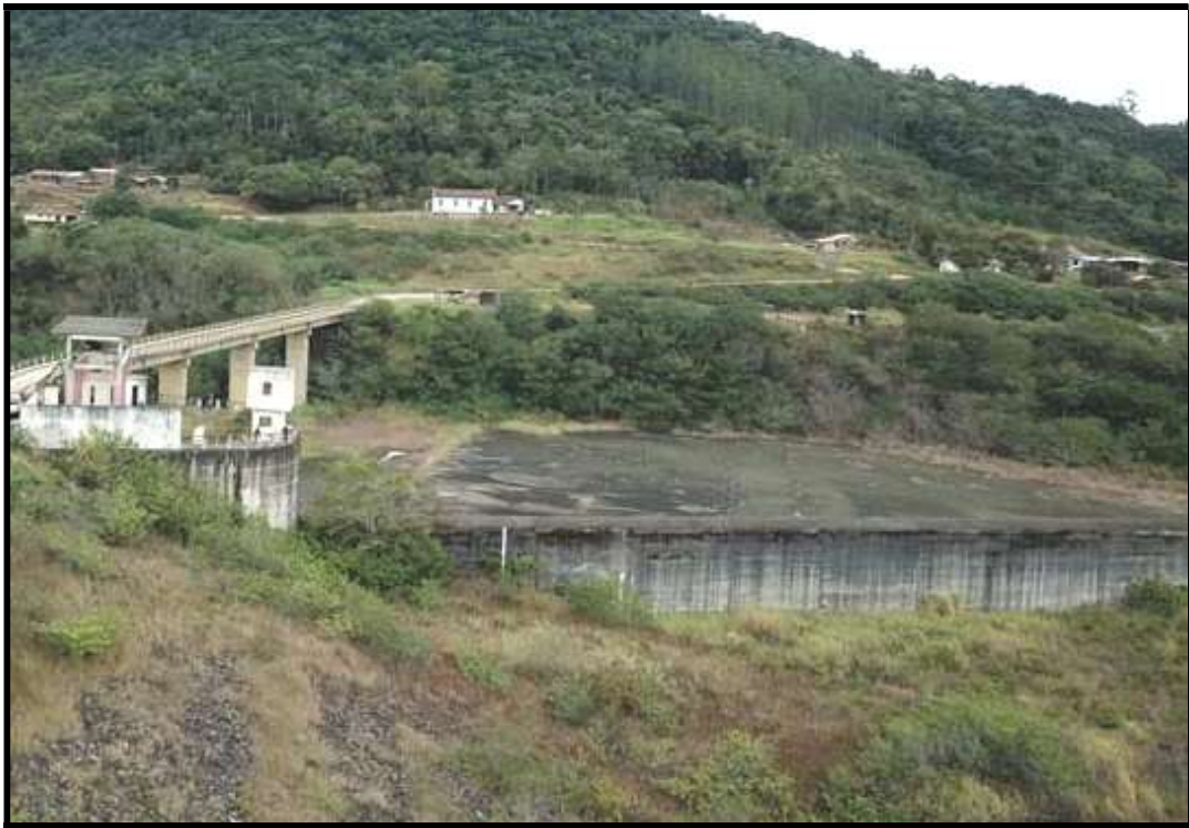
Foto 8 – Ombreira esquerda a montante, com parte superior em encosto na estrutura de concreto e na porção inferior em terreno natural, com presença de árvores e arbustos.
