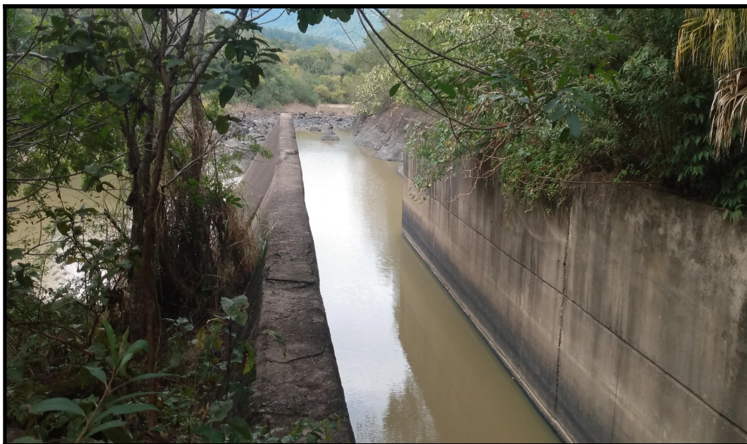
Foto 42 – Boca de saída do túnel externo, com vista do talude rochoso na lateral direita da do canal escavado a jusante .
