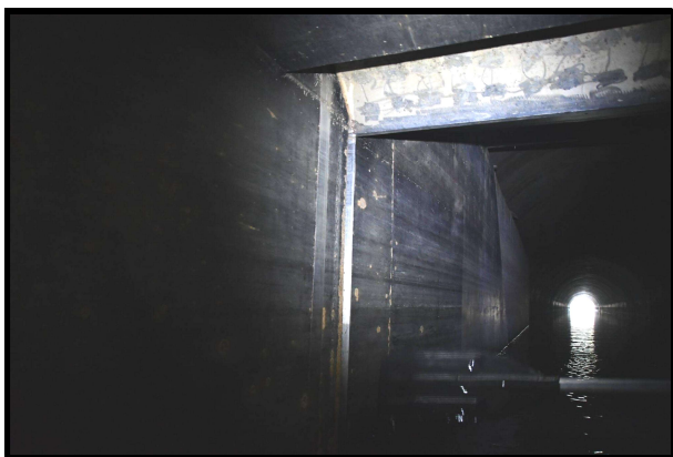
Foto 25 – Batente do Túnel Interno em bom estado.
