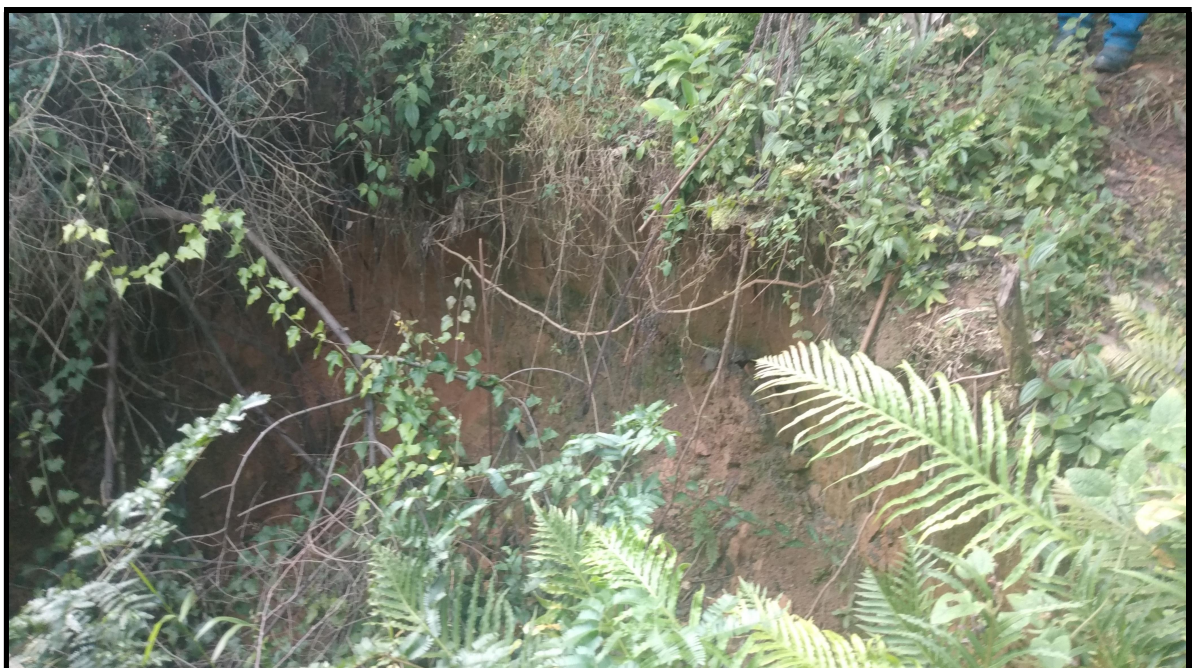
Foto 74 - Erosão em estrada de serviço abandonada da margem esquerda coord.: 26°53'30.60"S, 49°40'31.10"O.
