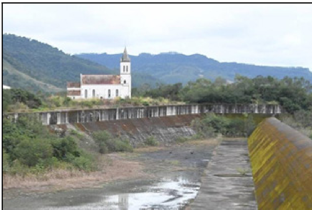
Foto 11 – Vista do muro de contenção do Canal de Restituição com presença de vegetação de médio porte.
