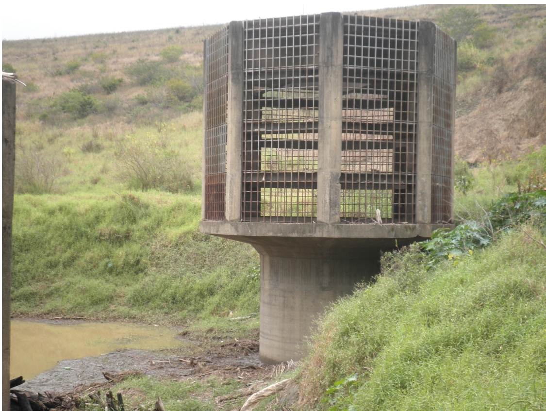
Foto 38 - Base da estrutura de emboque tipo tulipa do túnel interno (ou esquerdo) em bom estado
