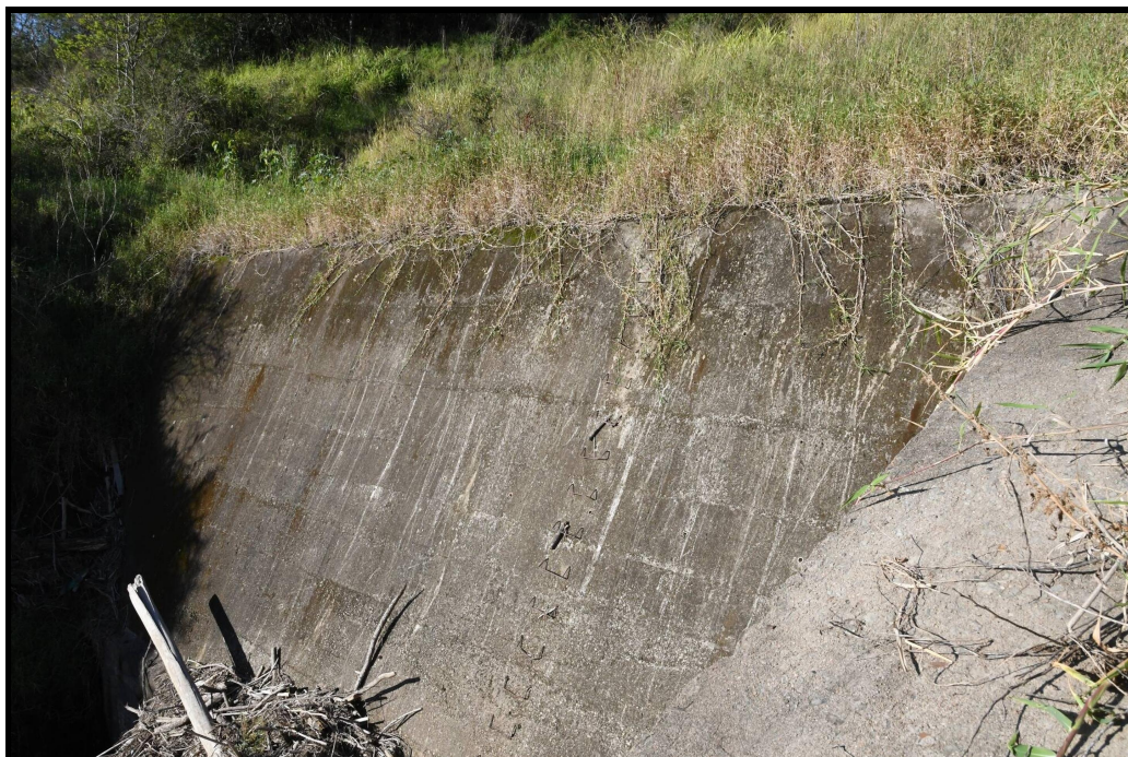
Foto 15 - Parede frontal do emboque da Galeria de Descarga em bom estado
