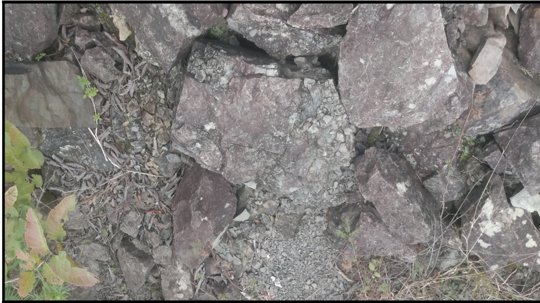
Foto 2 – Bloco de arenito do enrocamento apresentando desagregação devido à ação do intemperismo físico.
