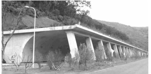
图2 傍山棚洞结构
