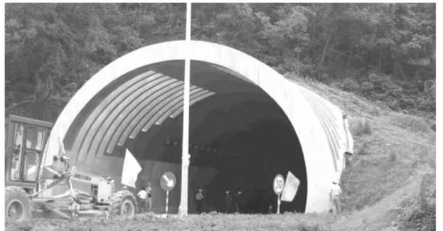
图3 前置式洞口结构
