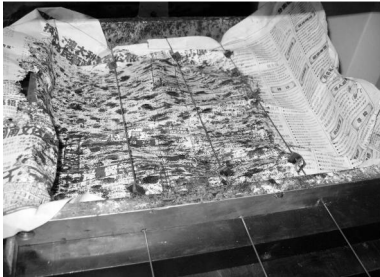
图 3 钢丝焊接角铁锚头丝
