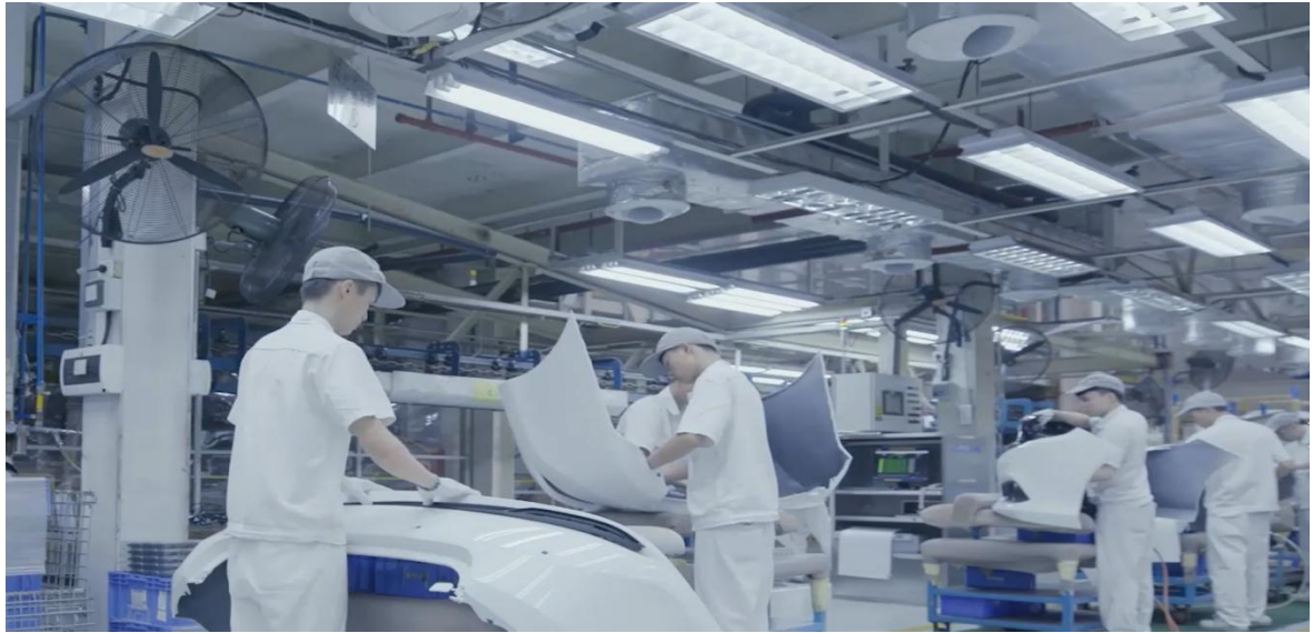
增加作业岗位空调送风口
