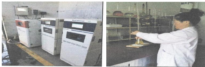
污水排放在线监测设备污水排放相关指标监测
